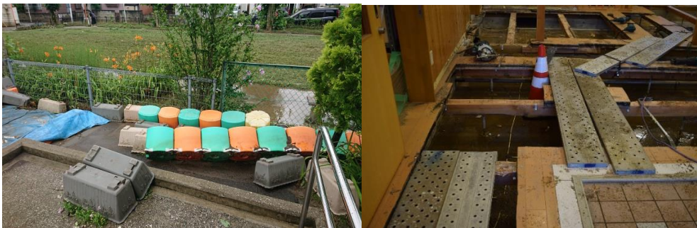
(写真左：被災直後の園庭 写真右：床下復旧工事の様子)
